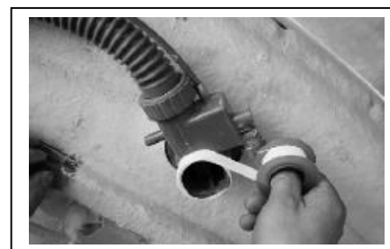
12. Kasutage äravoolu ühendamiseks kas toruteipi või sanitaarset hallituskindlat silikooni.
