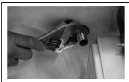
4. Paigaldage tihend ja keera segisti tugevalt kinni.
